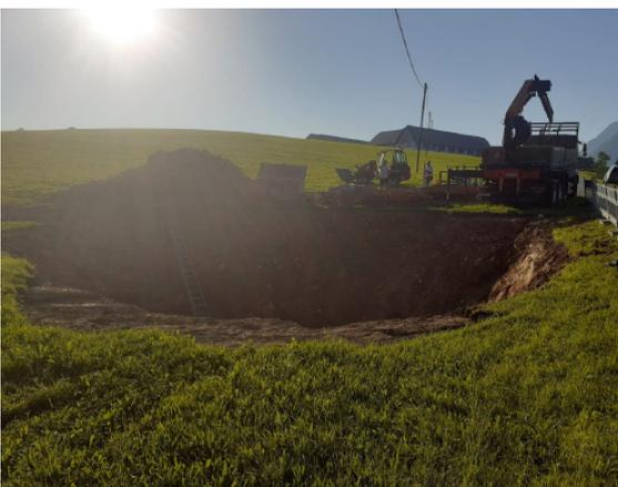
Foto: Bau des neuen Löschwasserbehälters Gaisriegl
